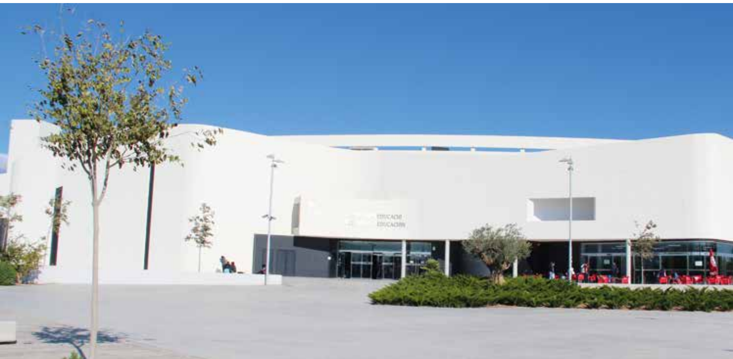
LA FACULTAD DE EDUCACIÓN ES EL PRIMER EDIFICIO UNIVERSITARIO DEL CAMPUS URBANO.
